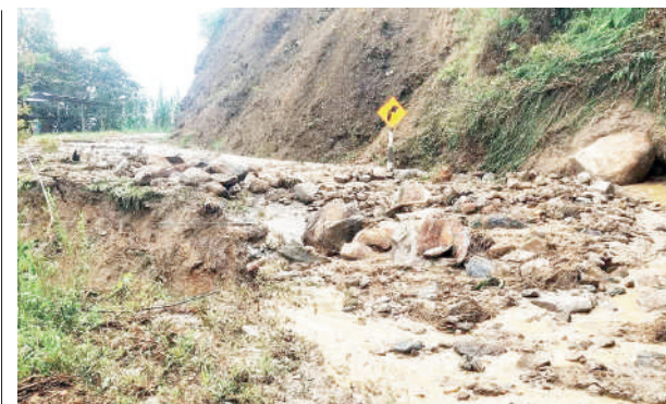
LODO Y PIEDRAS INTERRUMPEN TRÁNSITO A NAMBALLE.
