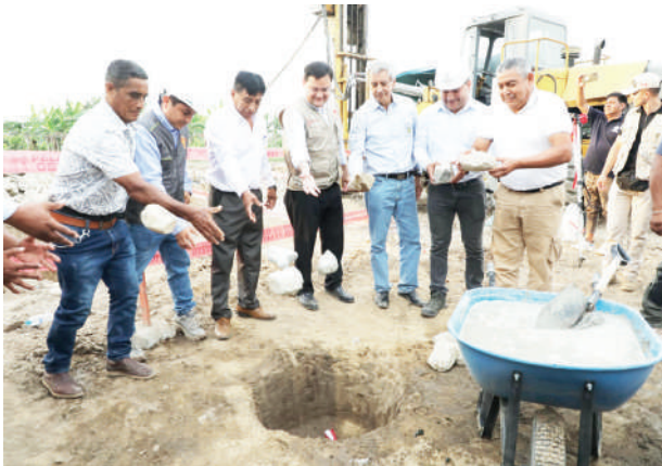
AUTORIDADES COLOCAN LA PRIMERA PIEDRA EN OBRA DE AGUA POTABLE.
