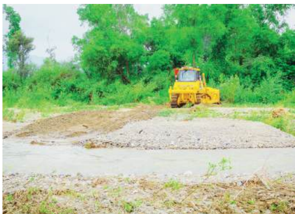
CON MAQUINARIA LIMPIARÁN 7,5 KILÓMETRO DEL RÍO TOCTO.
