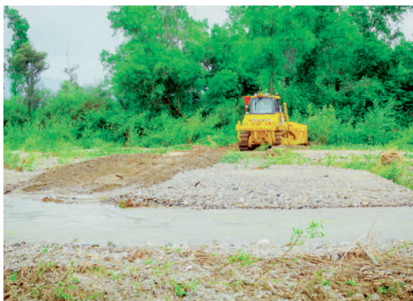
CON MAQUINARIA LIMPIARÁN 7,5 KILÓMETRO DEL RIO TOCTO.
