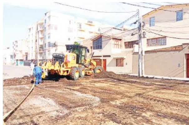
OBREROS DE LA MPCH RETIRARON EL ASFALTO DE LA CALLE CÚNEO.
