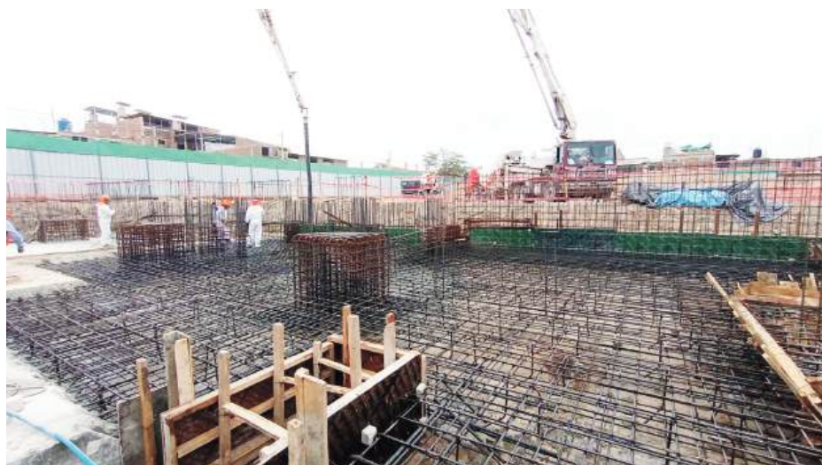
SIGUEN AVANCES EN OBRA DE CONSTRUCCIÓN DEL HOSPITAL DE FERREÑAFA.
