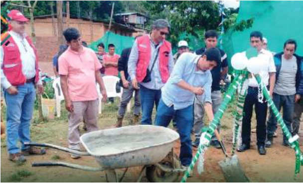
OBRA DE SANEAMIENTO COSTARÁ MÁS DE 8 MILLONES DE SOLES.
