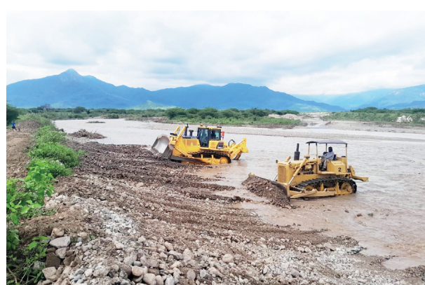
CON MAQUINARIA PESADA DESCOLMATAN Y LIMPIAN RÍOS.
