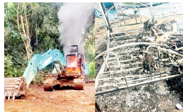
QUEMAN MAQUINARIA UTILIZADA POR MINEROS ILEGALES.
