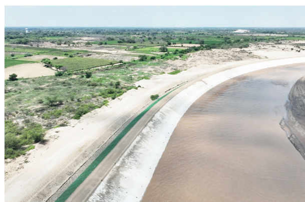
DEFENSAS RIBEREÑAS EN EL RÍO MOTUPE PARA PROTEGER A POBLACIÓN.
