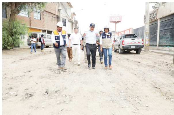
JORGE PÉREZ Y JANET CUBAS SUPERVISAN OBRAS VIALES.
