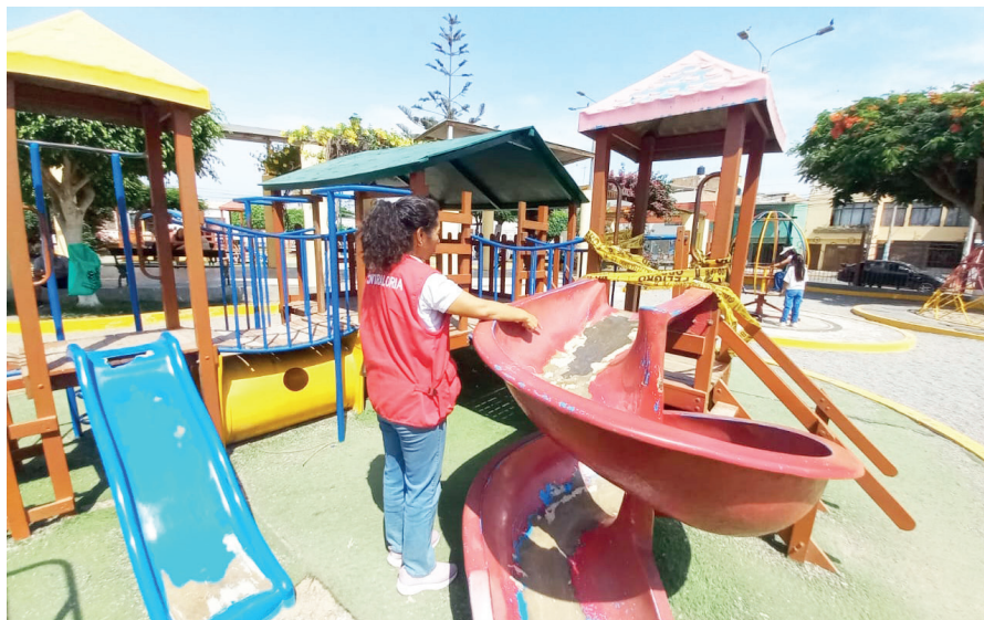
JUEGOS OXIDADOS Y ESTRUCTURAS DAÑADAS SON UN PELIGRO PARA LA INOCENCIA DE LOS MENORES.
