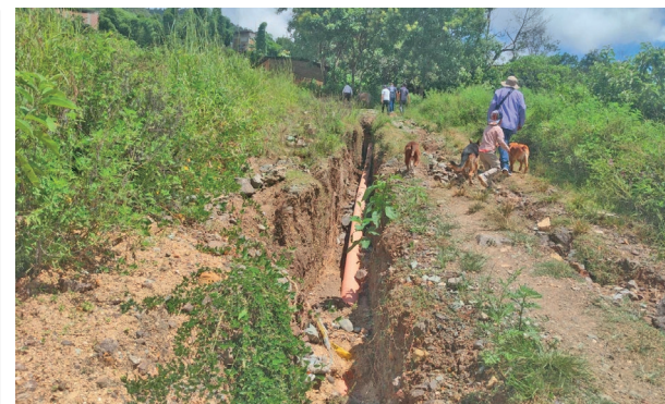
TROCHAS CARROZABLES ESTÁN INTRANSITABLES TRAS LLUVIAS.
