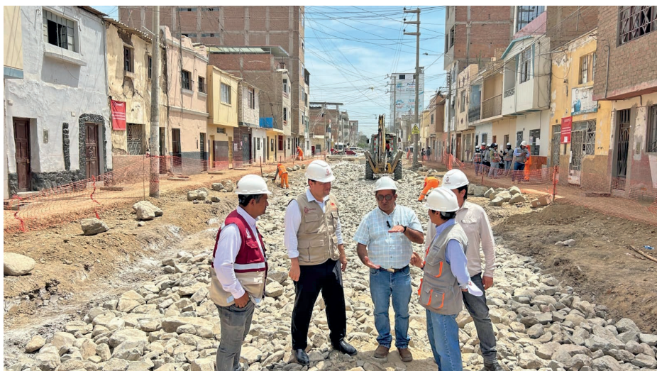
GOBERNADOR JORGE PÉREZ Y ALCALDE ELBER REQUEJO INSPECCIONAN OBRAS EN JLO.
