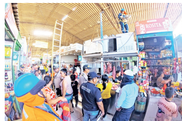
CONEXIONES CLANDESTINAS DE ENERGÍA EN MOSHOQUEQUE.
