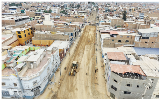
OBRA DE PAVIMENTACIÓN SE EJECUTA CON ENFOQUE EN DURABILIDAD Y SANEAMIENTO
