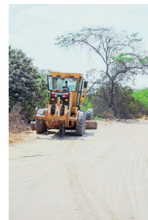
SUPERVISIÓN DE TRABAJOS.
