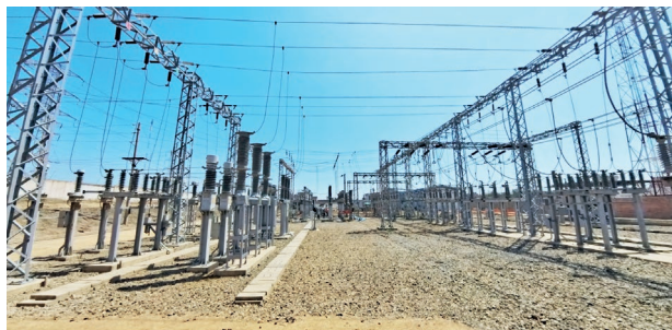
CORTE MASIVO DE ENERGÍA ELÉCTRICA ESTE DOMINGO 24 DE MAYO POR TRABAJOS DE ALTA TENSIÓN.
