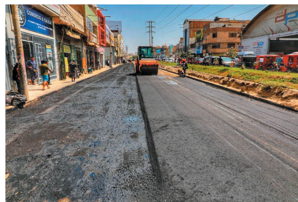
TRABAJOS DE ASFALTADO DE LA AVENIDA AUGUSTO B. LEGUÍA.
