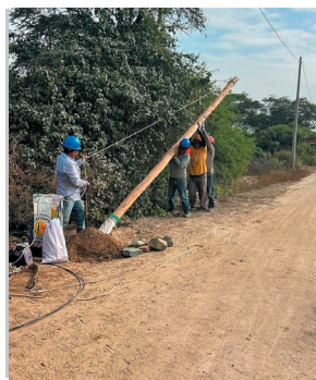
CAMBIO DE PORTES EN MAL ESTADO EN ÍLLIMO.
