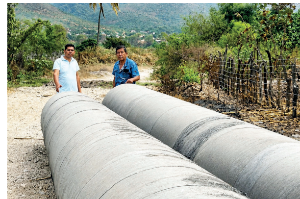
TUBERÍA DE ACERO PARA PROTEGER INFRAESTRUCTURA DE RIEGO.
