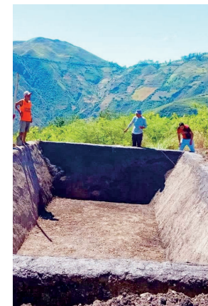
RESERVORIO EN TAILÍN.
