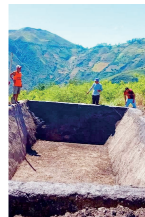
RESERVORIO EN TAILÍN.
