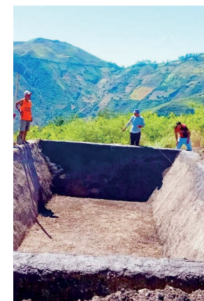
RESERVORIO EN TAILÍN.
