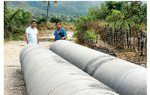
TUBERÍA DE ACERO PARA PROTEGER INFRAESTRUCTURA DE RIEGO.
