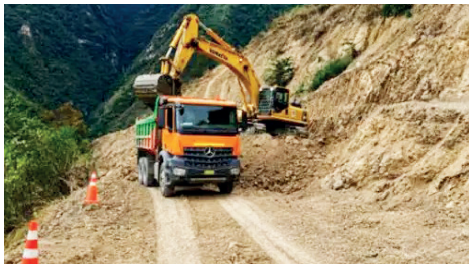
OBRA EJECUTADA POR CONCESIONARIA IIRSA NORTE MEJORARÁ TRÁNSITO VEHICULAR EN UTCUBAMBA
