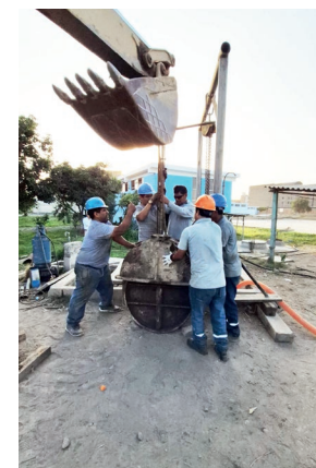
REPARAN AVERÍA EN VÁLVULA.
