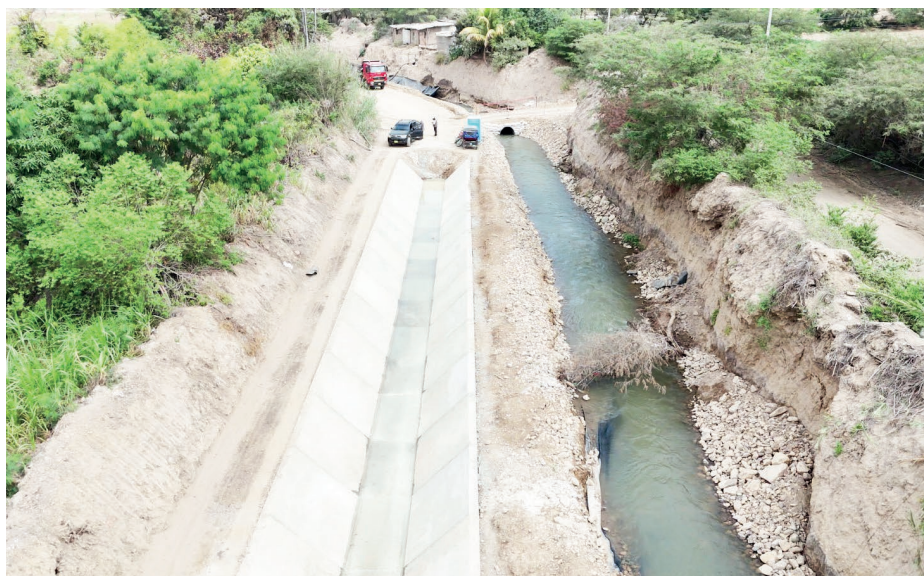
OBRA COMPRENDE EL REVESTIMIENTO DE 20 KILÓMETROS DEL CANAL DE PAMPAGRANDE.
