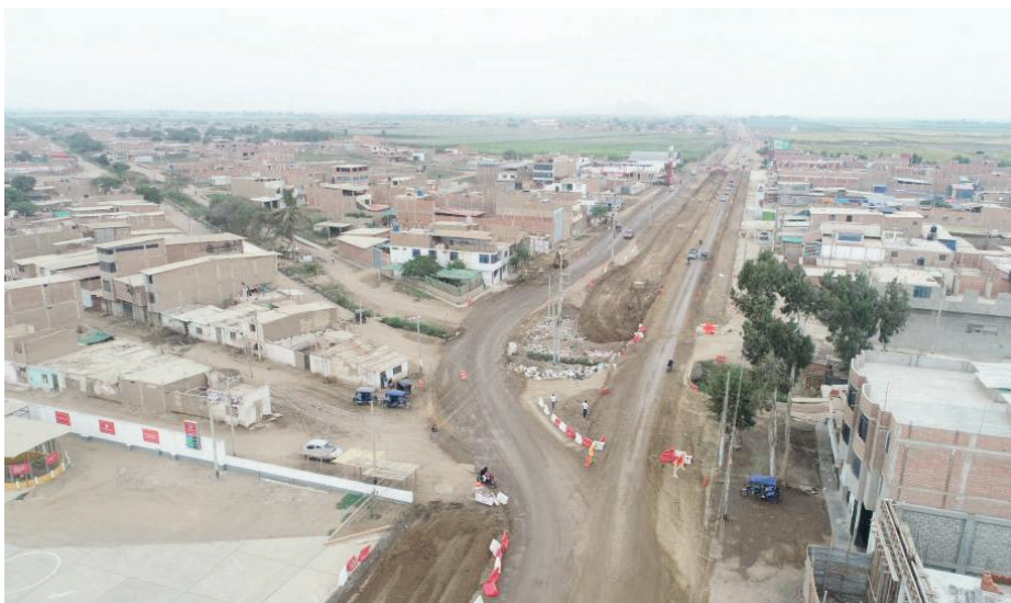
RED VIAL CHICLAYO POMALCA ES UNA MEGA OBRA QUE SE EJECUTA A TRAVÉS DE OBRAS POR IMPUESTOS.
