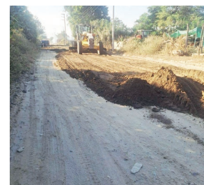
TRABAJOS DE MANTENIMIENTO.
