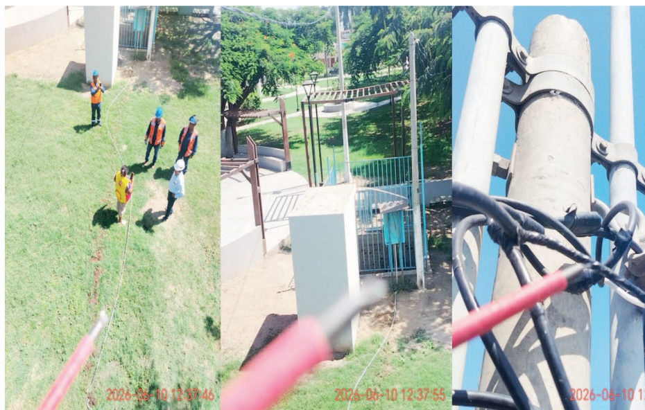
PERSONAL DE ENSA RETIRA CABLES DE LOCALES DE LA MUNICIPALIDAD DISTRITAL DE PÁTALO.
