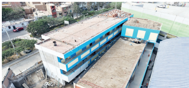
UN 95% DE AVANCE REGISTRA OBRAS EN EL COLEGIO MIGUEL MURO ZAPATA.
