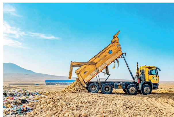
OBRAS DEL RELLENO SANITARIO TIENE UN AVANCE DEL 95%.
