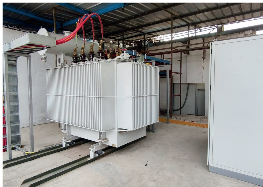
EN POMALCA SE AVANZA INSTALACIÓN DE UN POTENTE TURBOGENERADOR DE 13.7 MW.
