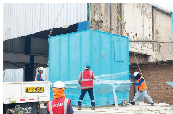
ARRIBARON DOS TORRES DE ENFRIAMIENTO DE ALTA TECNOLOGÍA,
