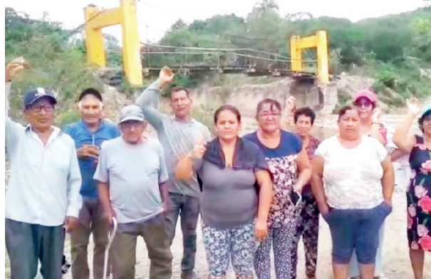
POBLADORES DENUNCIARON ABANDONO DE OBRA DEL PUENTE.
