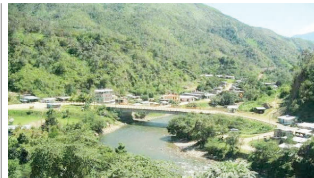
PUENTE INTERNACIONAL LA Balsa ESTÁ CERRADO DESDE EL 2025.
