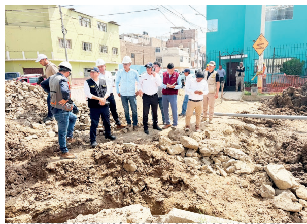
JORGE PEREZ SUPERVISÓ OBRA EN CALLE LORA Y CORDERO.
