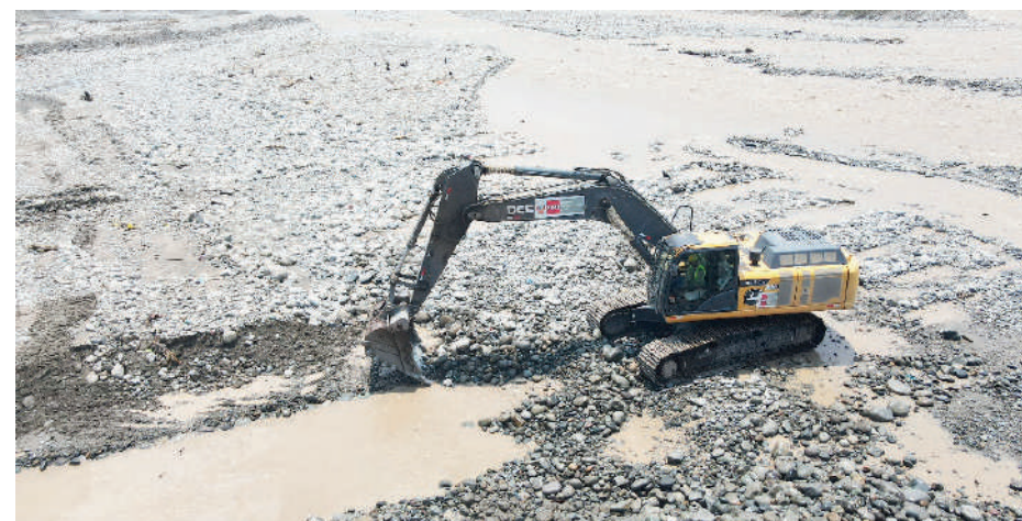
MAQUINARIA TRABAJA EN DESCOLMATACIÓN DE RÍOS.
