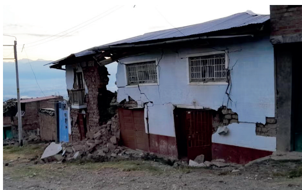
SISMO DEJÓ 48 VIVIENDAS DESTRUIDAS EN PUMPUNYA.
