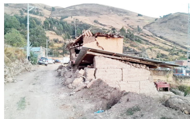
MAS DE 250 CASAS FUERON AFECTADAS POR EL SISMO EN JUNIN.
