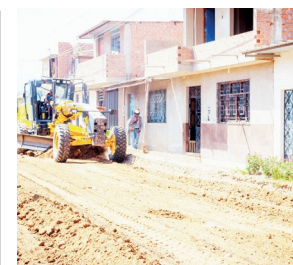
INICIAN OBRAS EN OLMOS.
