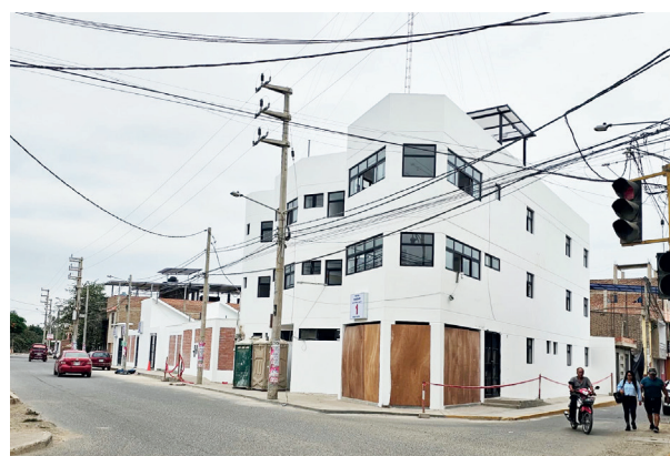
SE CULMINÓ OBRAS DEL HOSPITAL DE SOLIDARIDAD DE FERREÑAFE.
