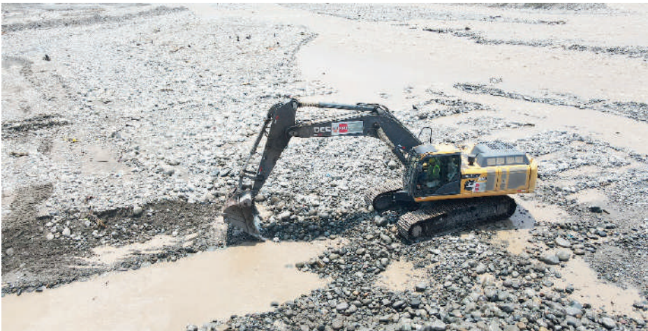
MAQUINARIA TRABAJA EN DESCOLMATACIÓN DE RÍOS.
