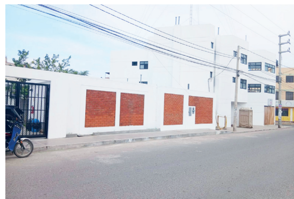
CULMINAN OBRAS EN EL HOSPITAL DE LA SOLIDARIDAD DE FERREÑAFE
