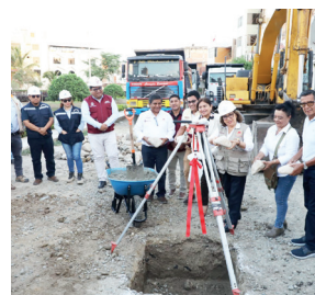
PRIMERA PIEDRA DE OBRA.
