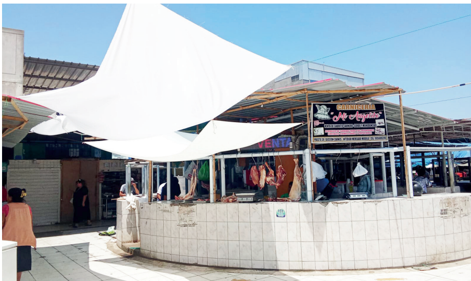
TRABAJOS ESTARÍAN ARRANCANDO EN AGOSTO EN SECTOR DE HIDROBIOLÓGICOS EN EL MODELO.
