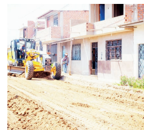
INICIAN OBRAS EN OLMOS.
