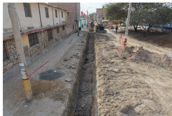
RENOVARÁN REDES Y PISTAS EN CALLES DE URB. QUIÑONES.
